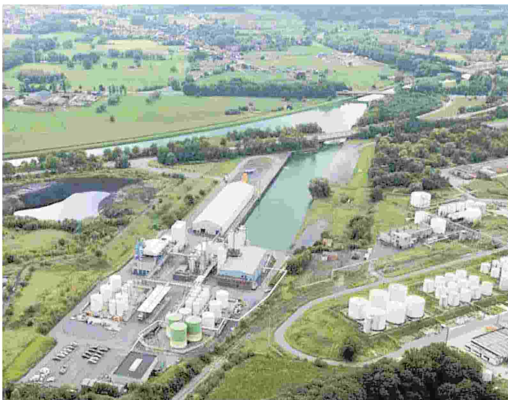
Veduta aerea degli impianti della società belga Advachem appena acquisita dal gruppo Saviola
